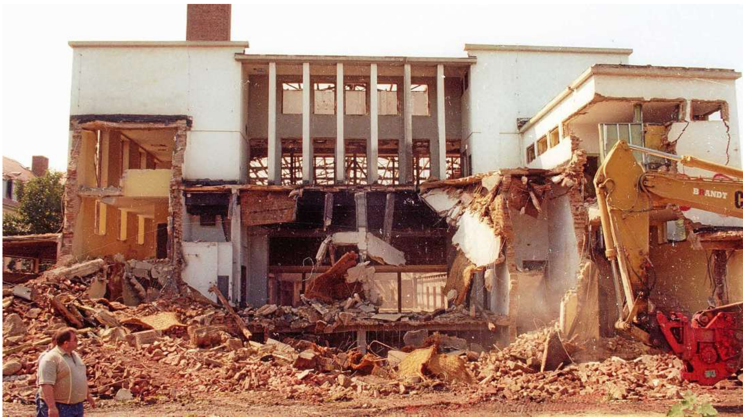
Diese Aufnahme vom Abriss der alten Weimarahalle entstand am 29. Juli 1997.
