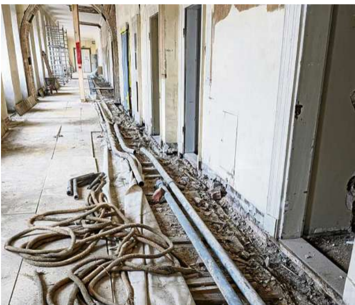
Rückbau einer Heizungsanlage im Westflügel.
