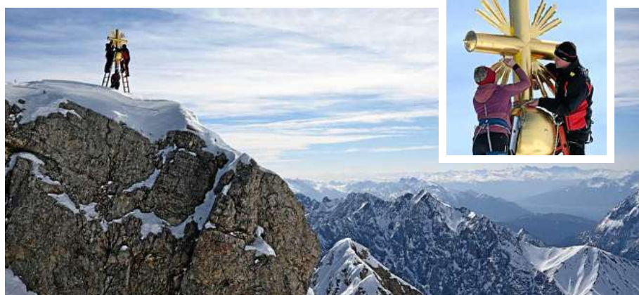
Die im Tal restaurierten Strahlen des Gipfelkreuzes werden von Mitarbeitern wieder am Gipfelkreuz angebracht. ANGELIKA WARMUTH (2) / DPA
