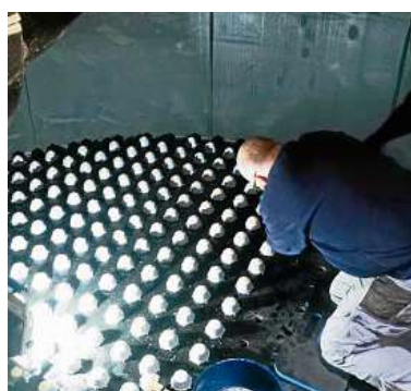
Im Freibad Mosbach sind in Vorbereitung der Saison 2024/2025 die Sandfilter ausgetauscht worden.
