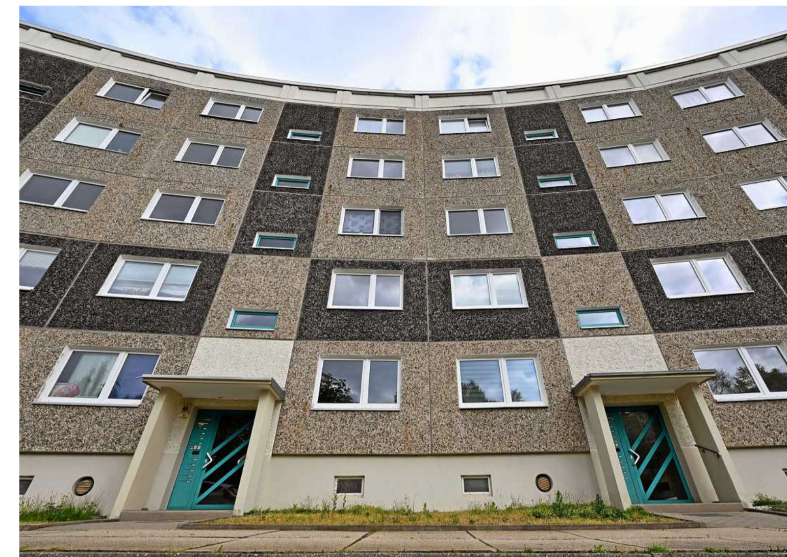
Ein Plattenbau in der Rudolstädter Straße in Gera-Lusan, der mittlerweile unter Denkmalschutz steht.
