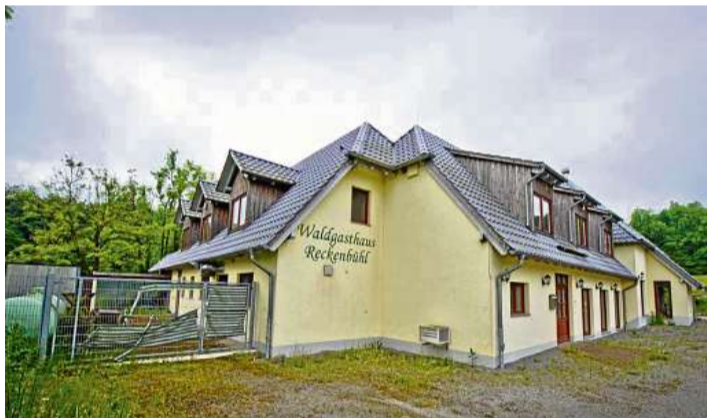
Der Bau des Waldgasthofes Reckenbühl hat Kammerforst über Jahre finanziell schwer belastet.
