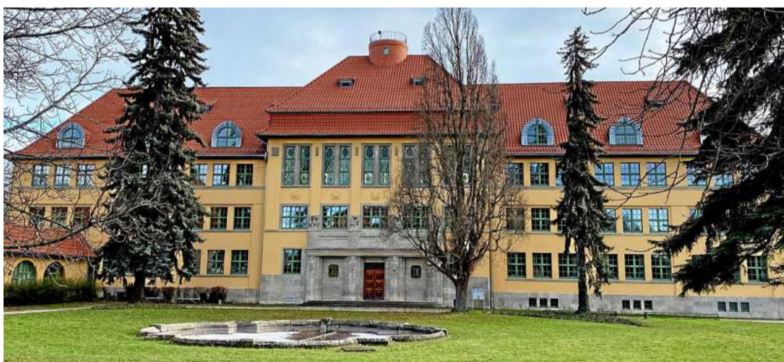
Die Sanierung der Regelschule „Am Schloss Neideck“ in Arnstadt war eines der größten Projekte im Ilm-Kreis. Weitere Schulbauvorhaben laufen und folgen.
