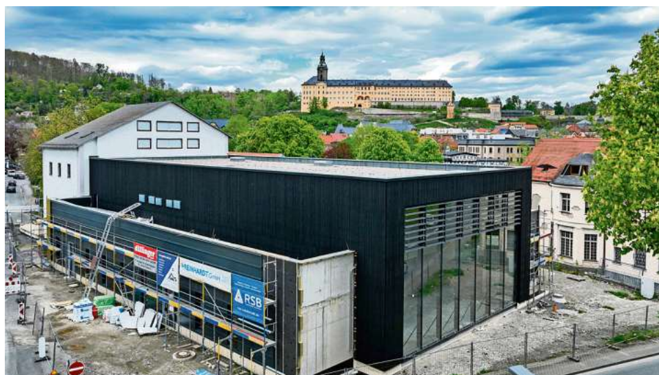
Das neue Rudolstädter Schillertheater vor der Kulisse der Heidecksburg.
