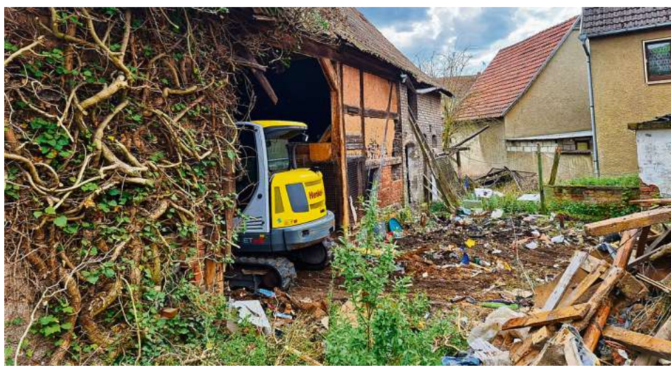
Der Abriss in der Suhler Straße 1 hat begonnen.
