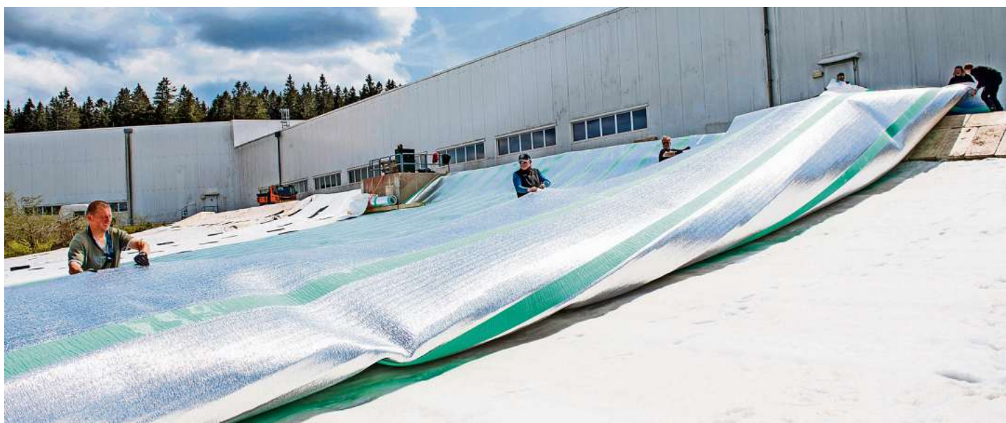
Neu: Mit modernen Vliesbahnen wird der Rest des Depots wenige Tage später akkurat verhüllt.
