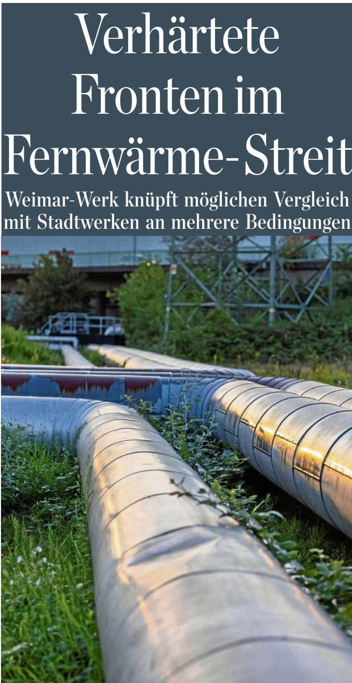
Fernwärme-Rohre laufen durch eine Grünfläche. THOMAS BANNEYER/DPA
