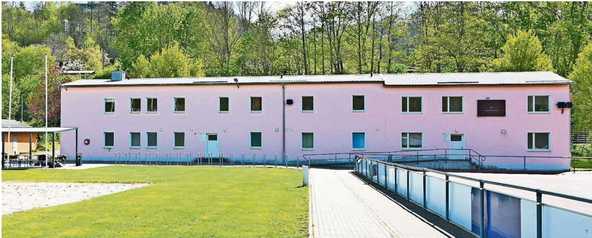
Das Funktionsgebäude im Stadion „Maßfelder Weg“ wird neu errichtet.
