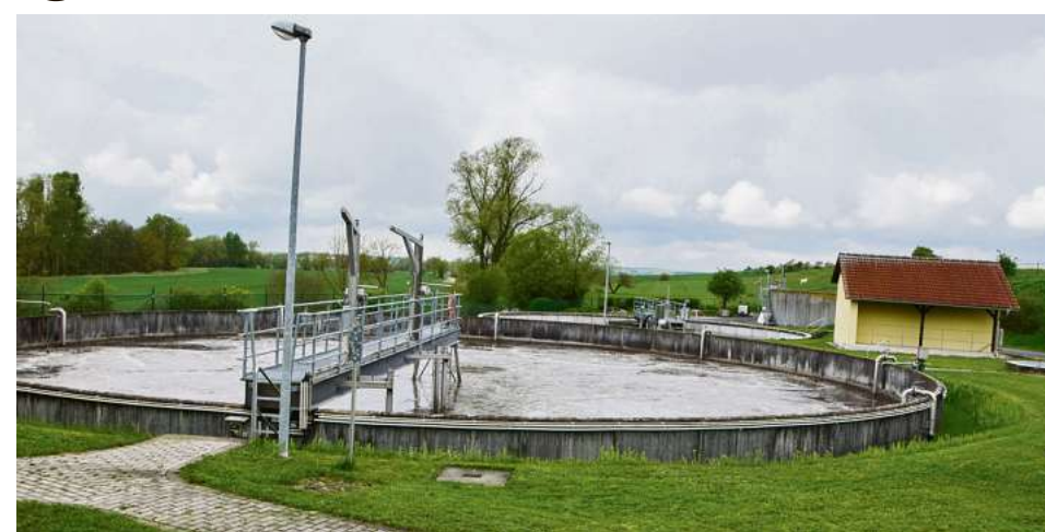
Weil sich das Abwasser verändert, muss die Kläranlage Milz umgebaut werden. Foto: Kurt Lautensack
