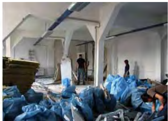
Umbau der 2nd Decade Etage
